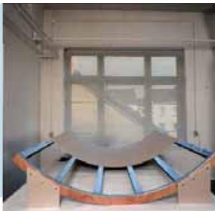
Изготовление элемента обшивки для криволинейной перегородки
