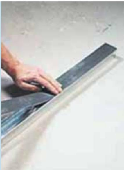
Направляющие и примыкающие к смежным стенам стоечные профили должны быть установлены на полиуретановую или пенорезиновую ленту.
