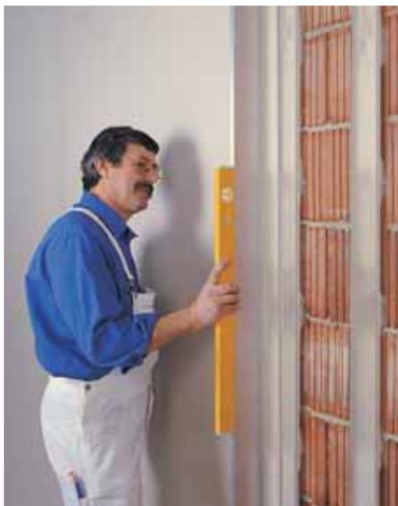
Неровные поверхности, такие как стены из кирпича, цементных блоков или камня, требуют нанесения более толстого слоя гипсового клея для приклеивания КНАУФ-листов. В этом случае рекомендуется использование клея КНАУФ-Перлфикс, который с помощью мастерка наносится по периметру и по середине листа точно через каждые 30 см. В узких местах гипсовый клей может быть нанесен непосредственно на стену. После нанесения клея лист устанавливается в вертикальном положении на подкладки и прижимается к стене.
