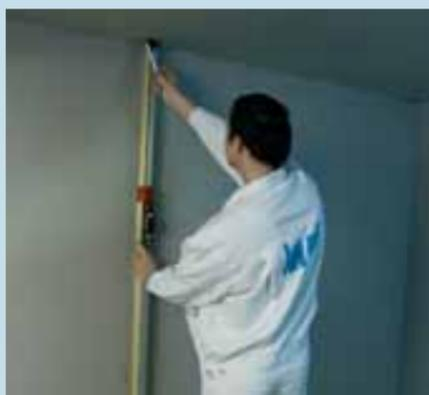
С помощью отвеса или специального уровня проводится ответная разметка на потолке.
