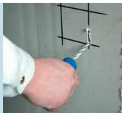
Отверстия для прямоугольных коробок прорезаются с помощью прокалывающего приспособления для фигурных отверстий
