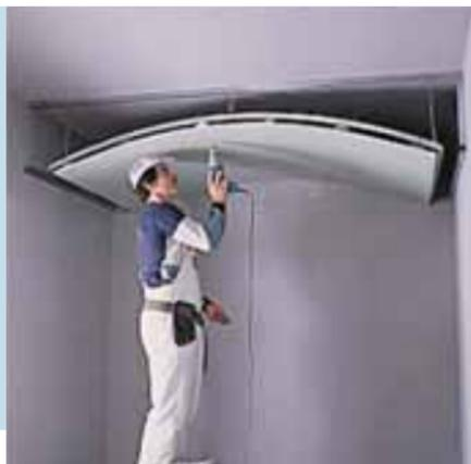
Установка и закрепление изогнутых листов обшивки
