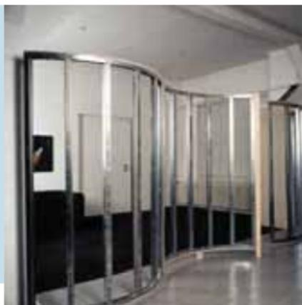
*Криволинейный металлический каркас перегородки*
