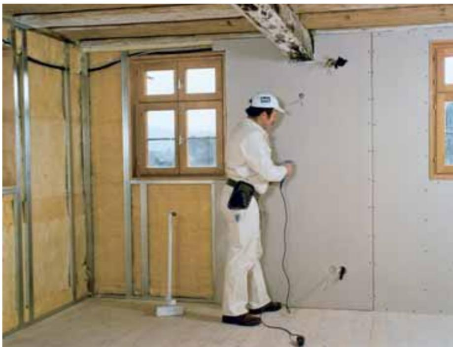
Облицовка стен КНАУФ-листами позволяет получать новые, идеально ровные, отделанные в соответствии с пожеланиями поверхности. С помощью комплекта облицовки КНАУФ можно легко добиться улучшения теплоизоляции и звукоизоляции помещений. Металлический каркас крепится у стены или к стене, заполняется изоляционным материалом, а затем к нему крепятся КНАУФ-листы. Процесс установки совершается одним из известных способов монтажа.
