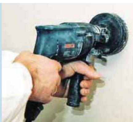
Прорезание отверстий в обшивке для установки круглой коробки легко производится с помощью специальной насадки к электродрели.
